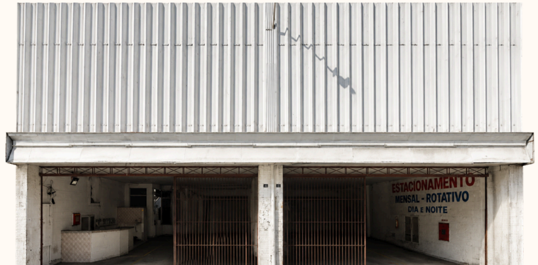
Fachada frontal do atual estacionamento
